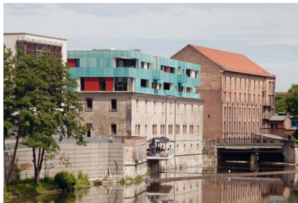
Umgestaltung des historischen Karlsruhospitals Kassel in Atelier-, Gastronomie- und Büroräume sowie Loftwohnungen
