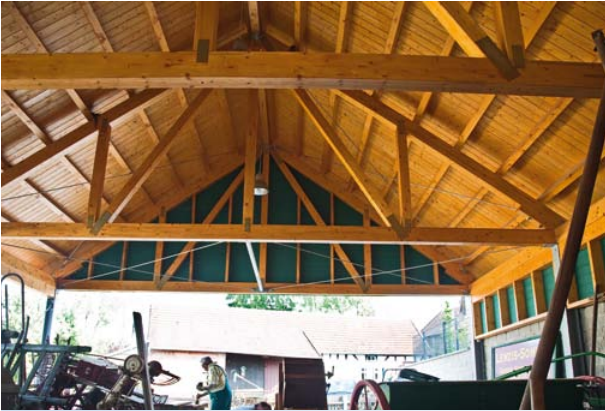
Landesprogramm „Einfache Stadterneuerung“: Neubau der Museumsscheune beim Heimatmuseum Lenzis in Flieden
