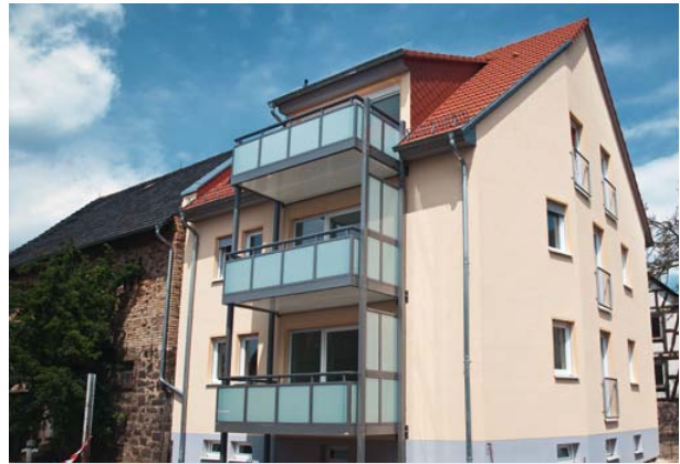
Neubau von fünf Sozialmietwohnungen durch die Baugenossenschaft Busecker Tal e. G. in Buseck, Oberpforte 9
