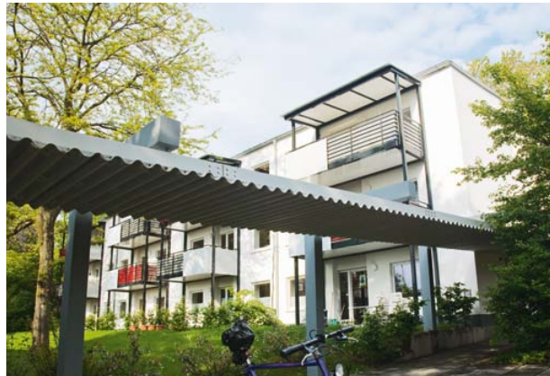
Wohnanlage der Wohnheim GmbH in Frankfurt, Johanna-Melber-Weg 11–21
